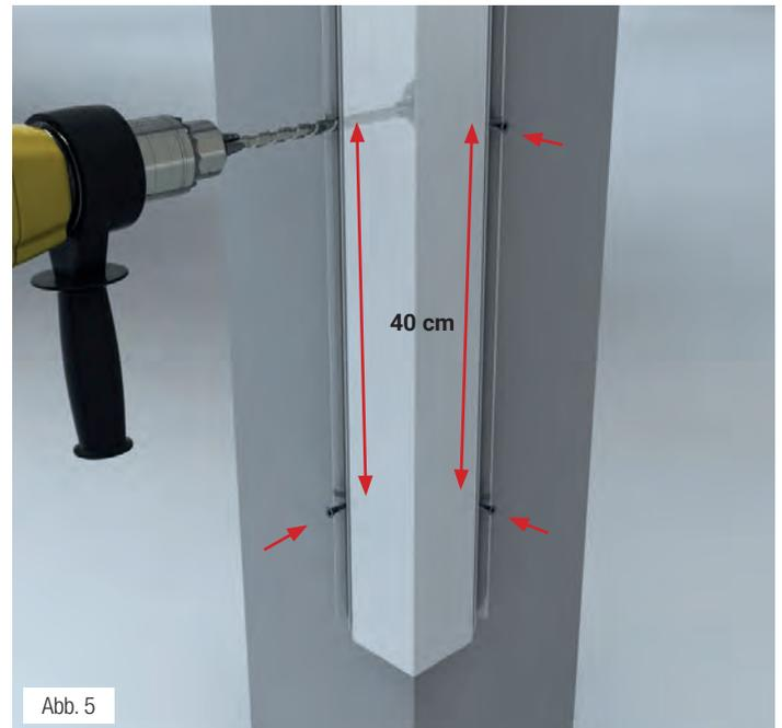
5. Bei der Montage des Zevener Eckprofils **4** muss ebenfalls auf das gesonderte Achsmaß geachtet werden. Bitte bohren Sie alle 40 cm mit einem 5-mm-Bohrer vor (Abb. 5) und befestigen Sie das Zevener Eckprofil mit einer 4,8 x 32 mm A2 Linsenkopfschraube.
