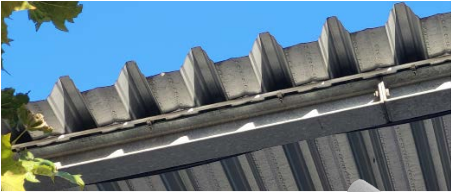
Abbildung zeigt die Tropfenbildung an einem Trapezprofil am morgen
